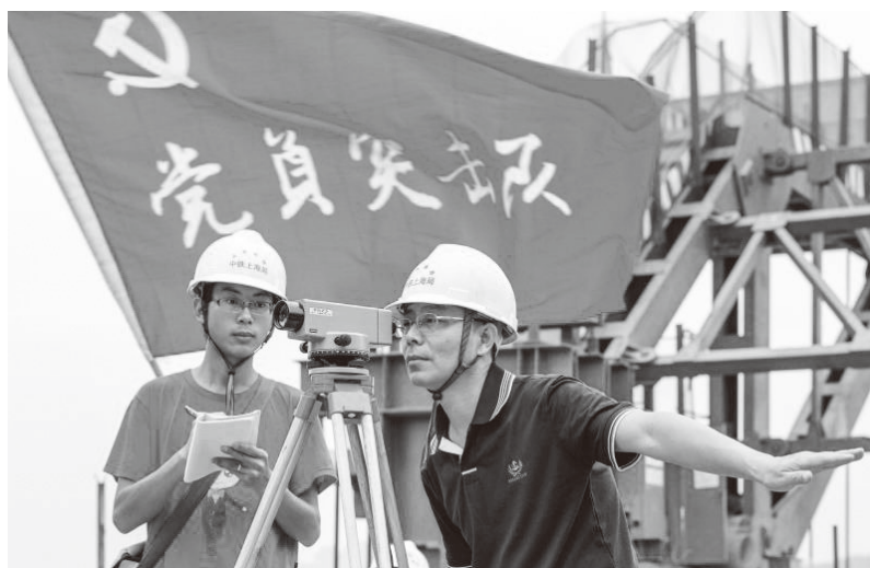
▲成贵铁路党员突击队队员进行现场测量工作
